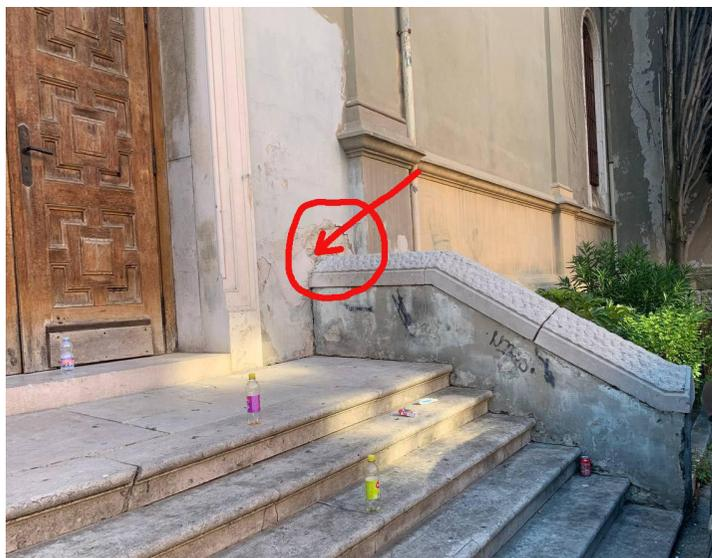
Da qualche tempo si stanno staccando parte degli intonaci nelle parti basse dei muri perimetrali esterni della chiesa e ultimamente si è verificato anche un cedimento del cordolo in pietra della scala laterale esterna con distacco di intonaco creando una notevole fessura
